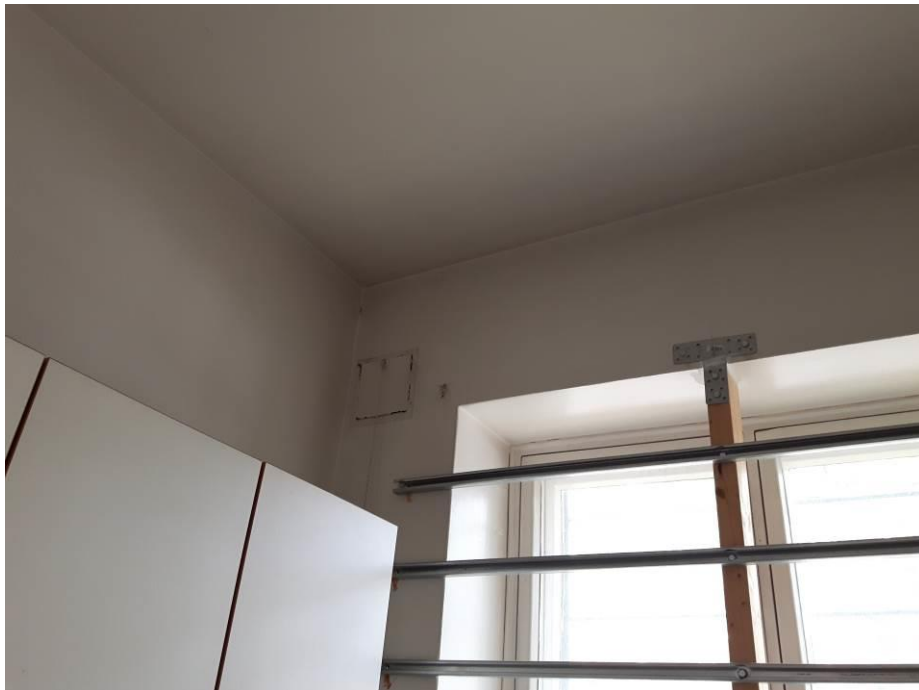
Kuva 30. Kärysaunan kattopinnoissa ei havaittu vaurioita.
