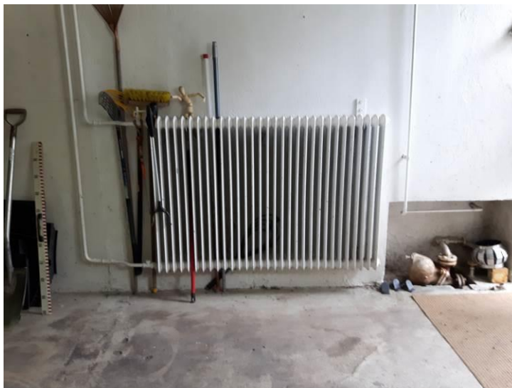
Kuva 7. Mehuaseman lattiassa on halkeamia.
