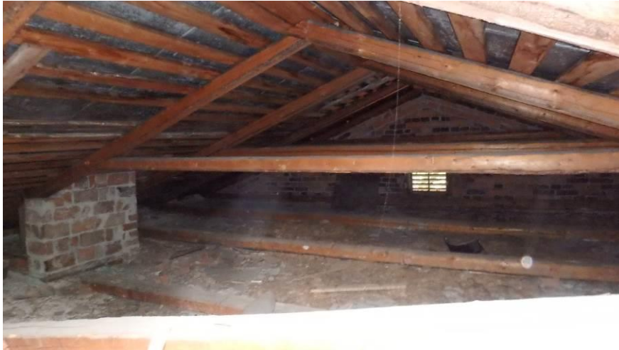
Kuva 9. Mehuaseman vesikaton alapuoliset rakenteet.
