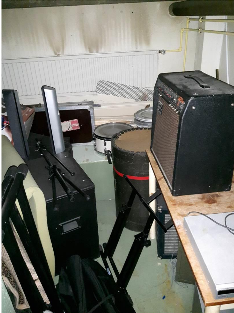
Kuva 41. Levypatteri ja termostaattinen patteriventtiili (90-luvulla uusittu)
