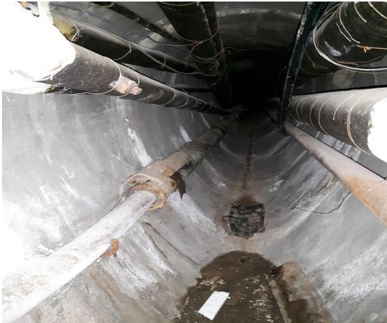
Kuva 37. Pihakanaali lämmönjakohuoneesta kuvattuna.
