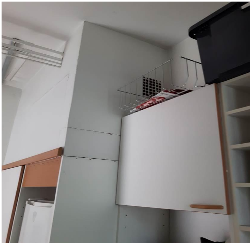
Kuva 42. Valurautainen poistoventtiili seinässä.
