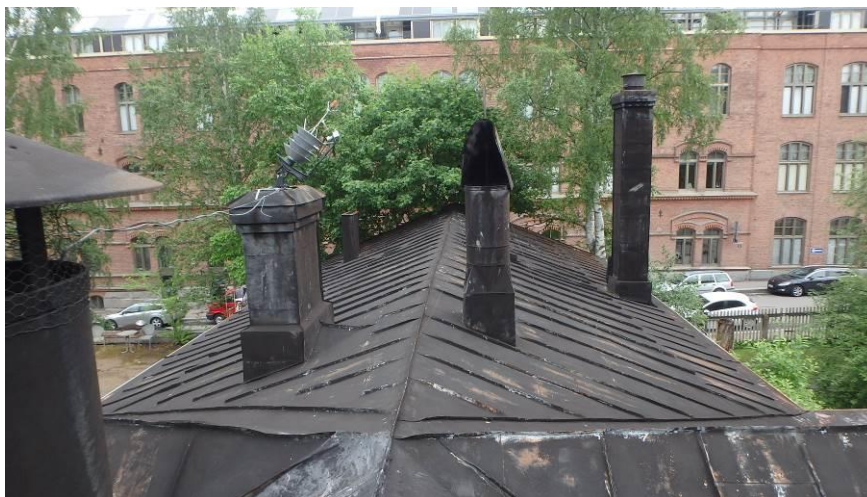
Kuva 24. Mehuaseman konesaumattu peltikatto.
