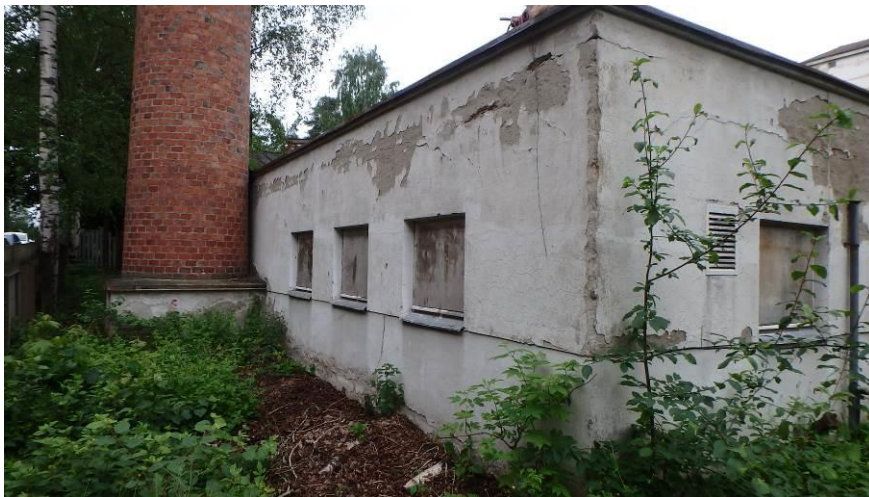
Kuva 3. Lämpövoimalan osalla on betoninen perusmuuri.
