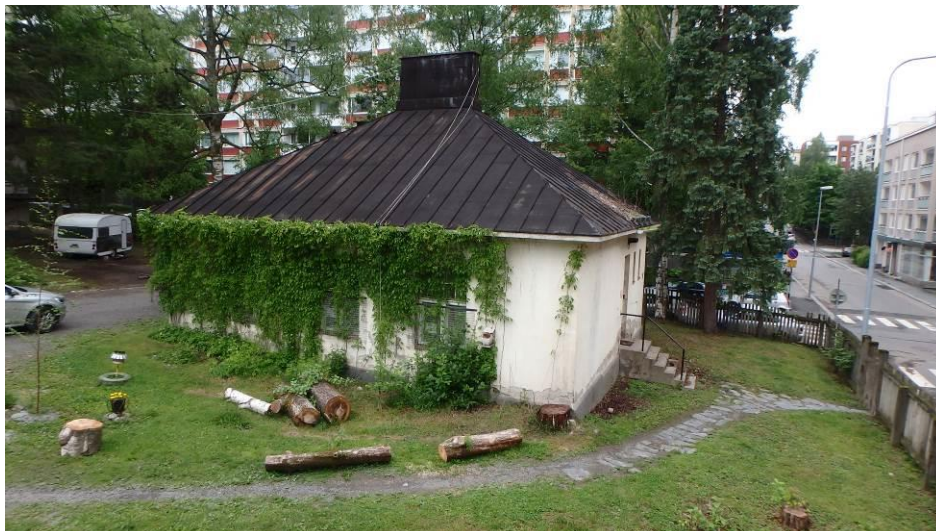
Kuva 22. Kärysaunan konesaumattu peltikatto.
