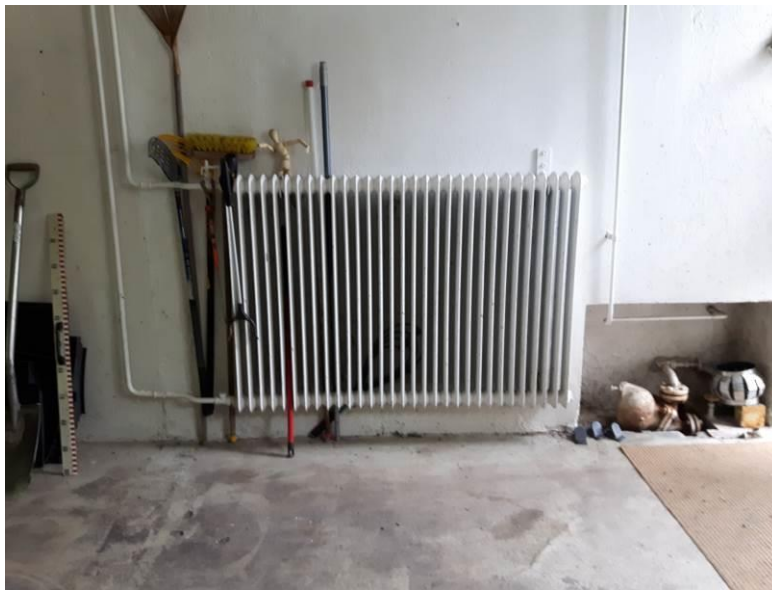
Kuva 40. Valurautainen patteri ja vanha patteriventtiili
